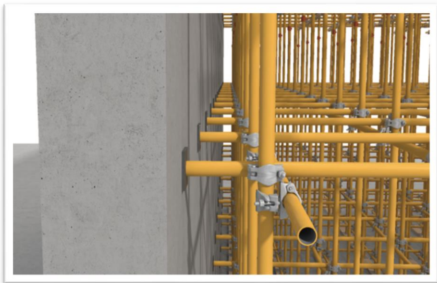
与墙顶紧顶牢
