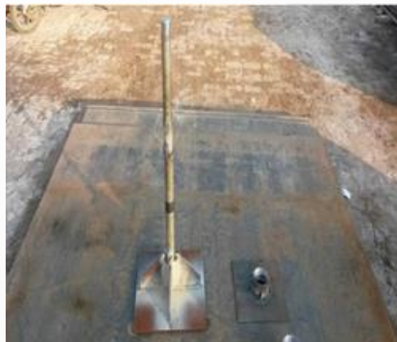
竖立回填土厚度标尺
