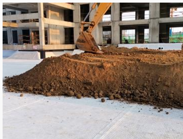
严格控制回填厚度
