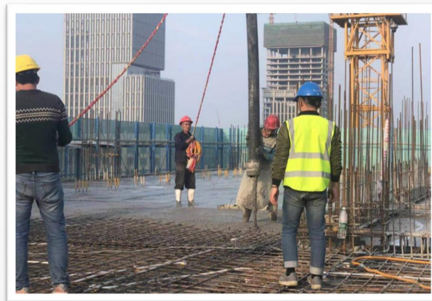
监理工程师旁站
