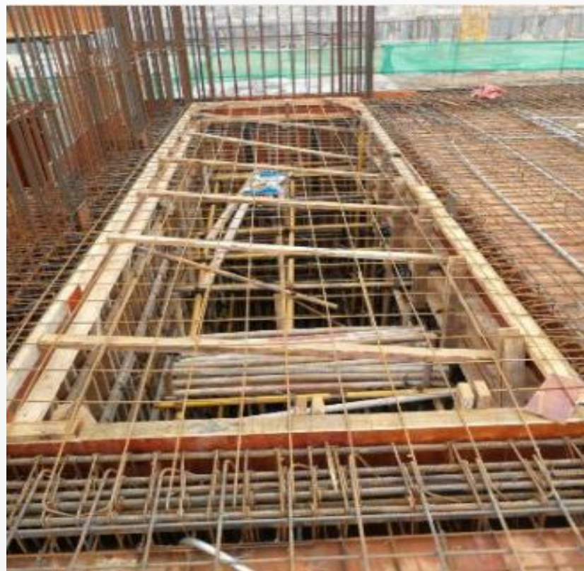
钢筋网防护（浇筑前）效果
