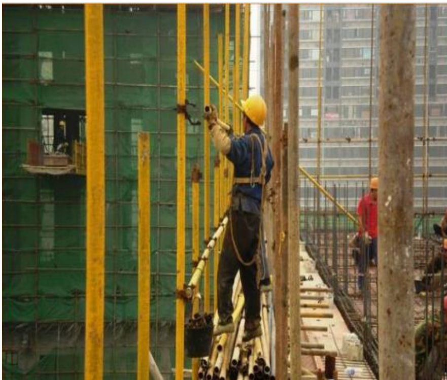
作业面脚手架搭设
