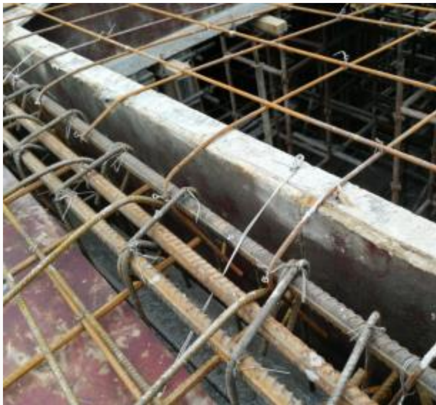
预留防护钢筋网绑扎
