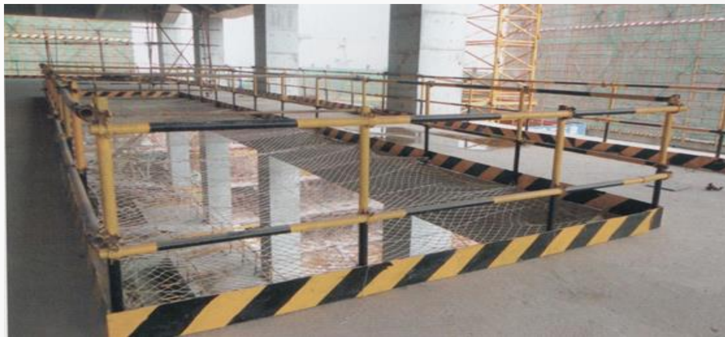
水平洞口防护
