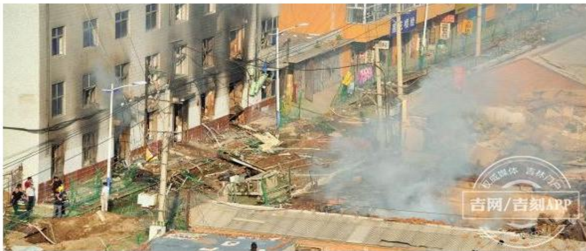
图2 燃气管道泄漏爆炸后现场
